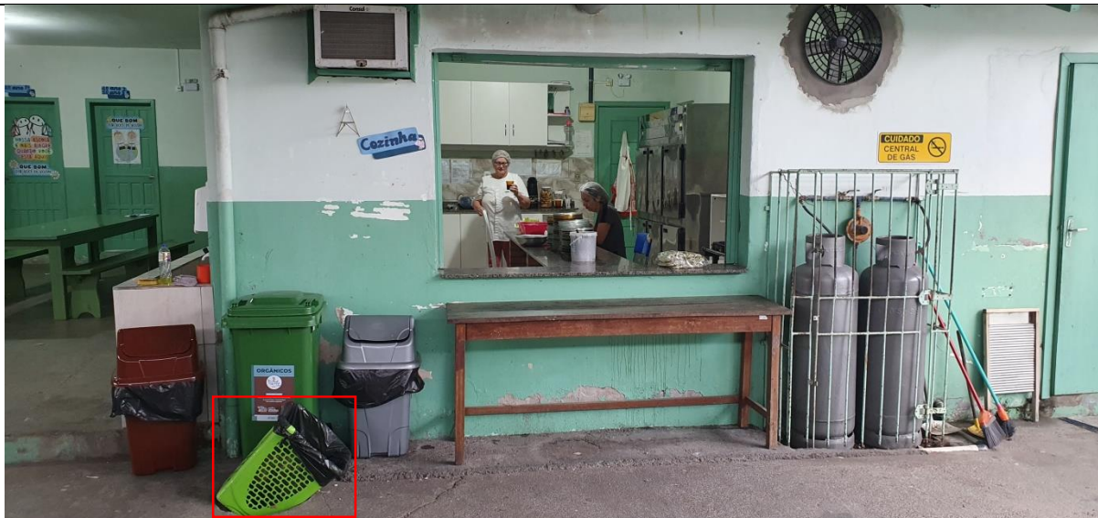
Foto 20: Escola Victória Cerutti Petters. Caixa de gordura tampada por cesto de lixo ao lado da mesa onde é servida a merenda
