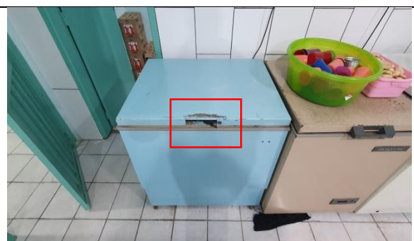
Foto 02: Escola Professor Wadislau Schmidt. Freezer não possui alça de abertura.
