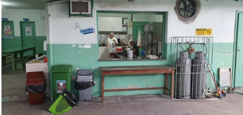
Foto 24: Escola Victória Cerutti Petters. Única abertura da cozinha, que fica aberta durante o expediente e exaustor sem telas
