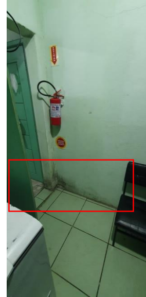
Foto 15: Escola Victória Cerutti Petters. Sem revestimento no almoxarifado com a existência de trincas, bolores e descascamentos
